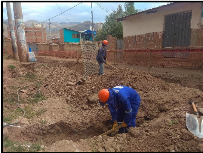
Foto 4: Excavación de zanjas para la reposición de conexiones
