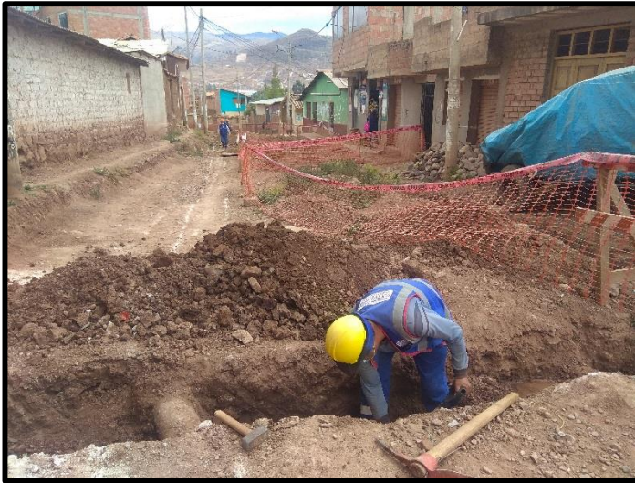
Foto 1: Excavación de zanjas para instalación de la tubería matriz de agua.
