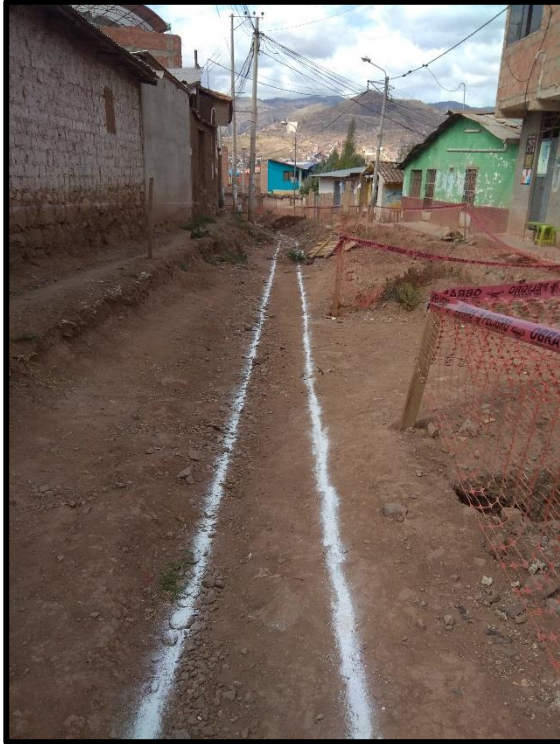
Foto 3: Trazo y replanteo de la red de desagüe
