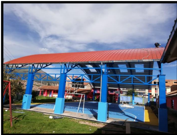
FOTO N° 02: II.EE. LOS NOGALES CULMINADA AL 100%
