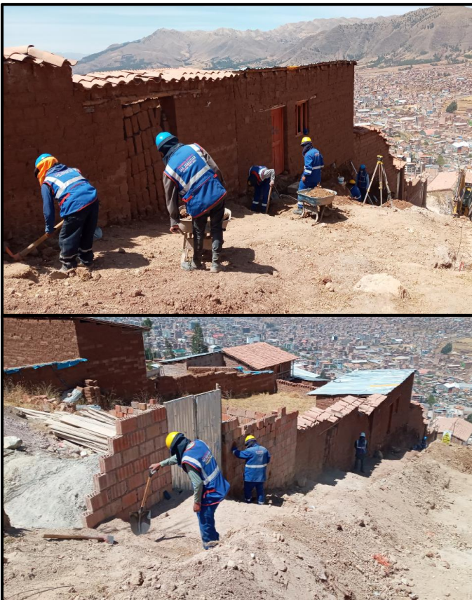
Foto n°4: Corte de terreno en la APV. Metropolitano de Alto Qosqo (2° calle)
