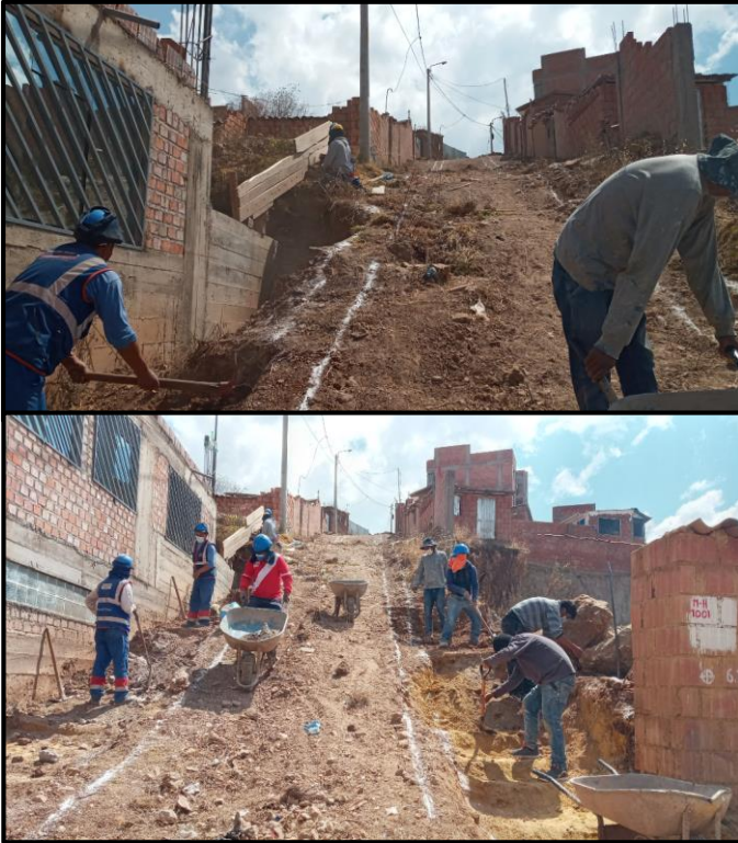
Foto n°3: Corte de terreno en la APV. Metropolitano de Alto Qosqo (1° calle)
